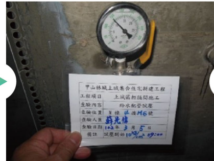
各戶給水系統試壓
