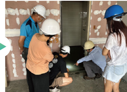
各戶浴室防水試水
