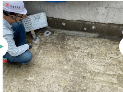
屋頂版防水試水
