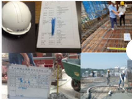
混凝土澆置(各樓層逐層邀請參訪)
